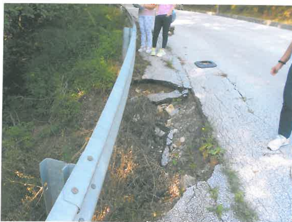
Φωτ: 7 Σημείο οδού πλησίον Μ. Ευμοίρου όπου υπάρχει καθίζηση της οδού.
