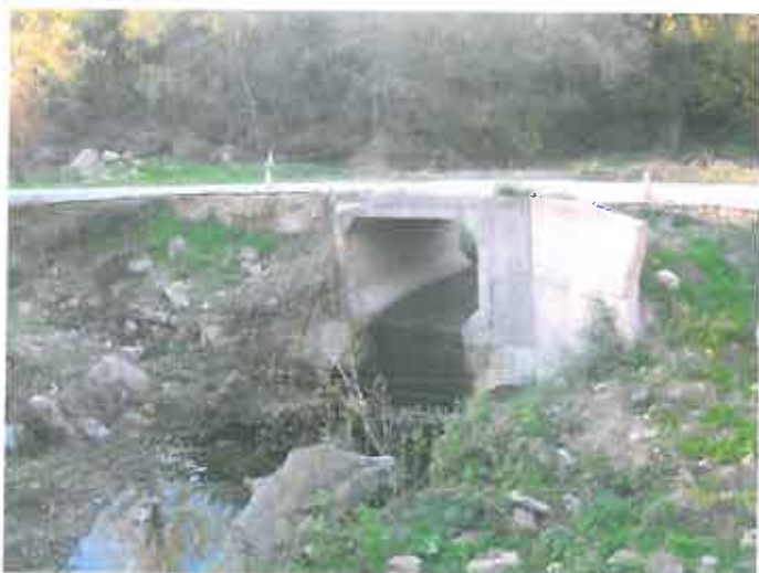
Φωτ: 5 Κατάντι όψη του τεχνικού διάβασης του υδατορέματος με εμφανής καθίζηση των πρανών.
