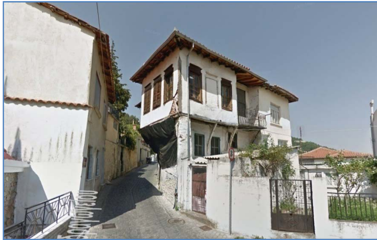
Εικόνα 6.8 – Σαχνισί κτιρίου επί των οδών Π. Χρηστίδη και Υδραγωγείου (άποψη από την οδό Π. Χρηστίδη)
