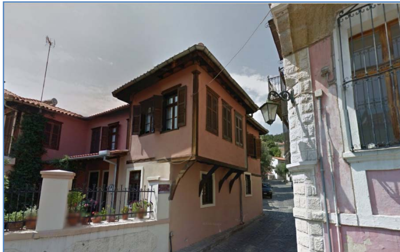
Εικόνα 6.7 – Σαχνισί κτιρίου επί των οδών Π. Χρηστίδη και Φιλίππου (άποψη από την οδό Φιλίππου)
