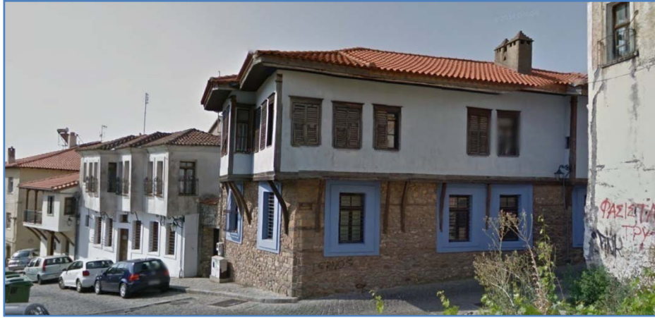
Εικόνα 6.6 – Σαχνισί κτιρίου Διεθνούς Δημοκρίτειου Ιδρύματος (άποψη από την οδό Γ. Αντίκα)
