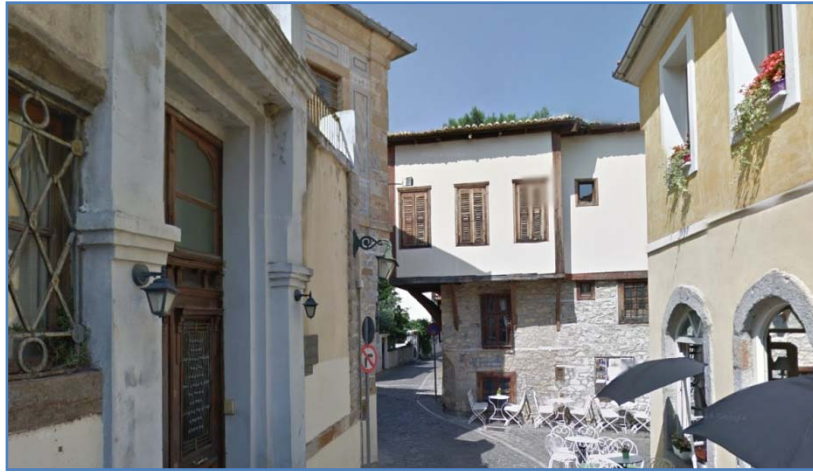
Εικόνα 6.4 – Σαχνισί κτιρίου Πινακοθήκης (άποψη από την οδό Ορφέως)
