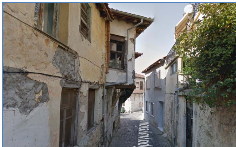
Εικόνα 6.9 – Σαχνισί κτιρίου επί των οδών Π. Χρηστίδη και Υδραγωγείου (άποψη από την οδό Υδραγωγείου)
