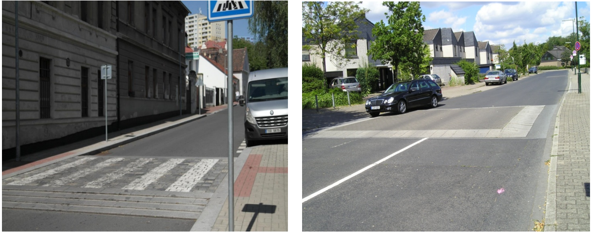
Εικόνα 5.13: Υπερυψωμένη διάβαση τραπεζοειδούς τύπου
