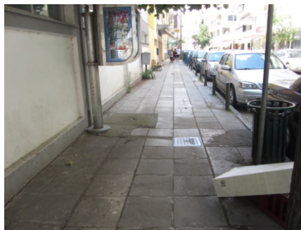
Φωτογραφία 5.8:Αποψη δεξιού πεζοδρομίου οδού 28ης Οκτωβρίου
