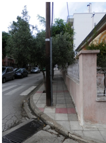
Φωτογραφία 5.21: Άποψη αριστερού πεζοδρομίου οδού Θυατείρων
