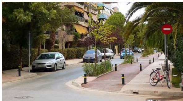
Φωτογραφία 5.43: Ενδεικτικός υποβιβασμός ποδηλατοδρόμου σε διασταυρώσεις
