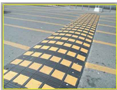
Εικόνα 5.1: Οδική ύβωση και μαξιλάρια
