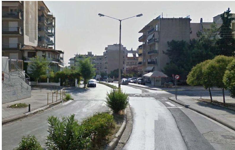
Φωτογραφία 5.58: Υφιστάμενη κατάσταση στην οδό Βλαχοπούλου
