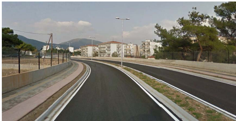
Φωτογραφία 5.40: Υφιστάμενος ποδηλατόδρομος στην οδό Σάρδεων
