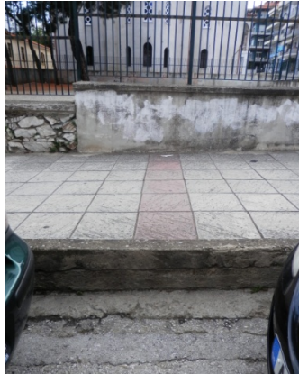
Φωτογραφία 5.20: Υψομετρική διαφορά πεζοδρομίου από το οδόστρωμα στην οδό Θυατείρων
