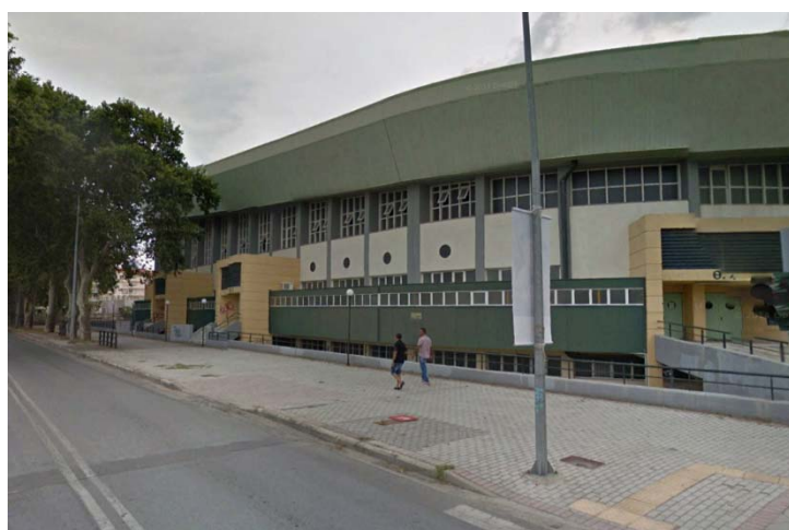
Φωτογραφία 4.15: Αθλητικό κέντρο Αμοιρίδειο
