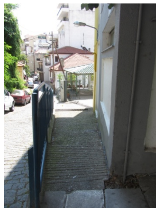
Φωτογραφία 5.11: Άποψη δεξιού πεζοδρομίου οδού Σερρών
