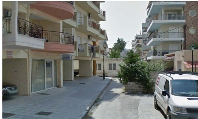
Φωτογραφία 8.1: Αδιάνοικτο τμήμα οδού Σκρα μήκους περί τα 20μ.
