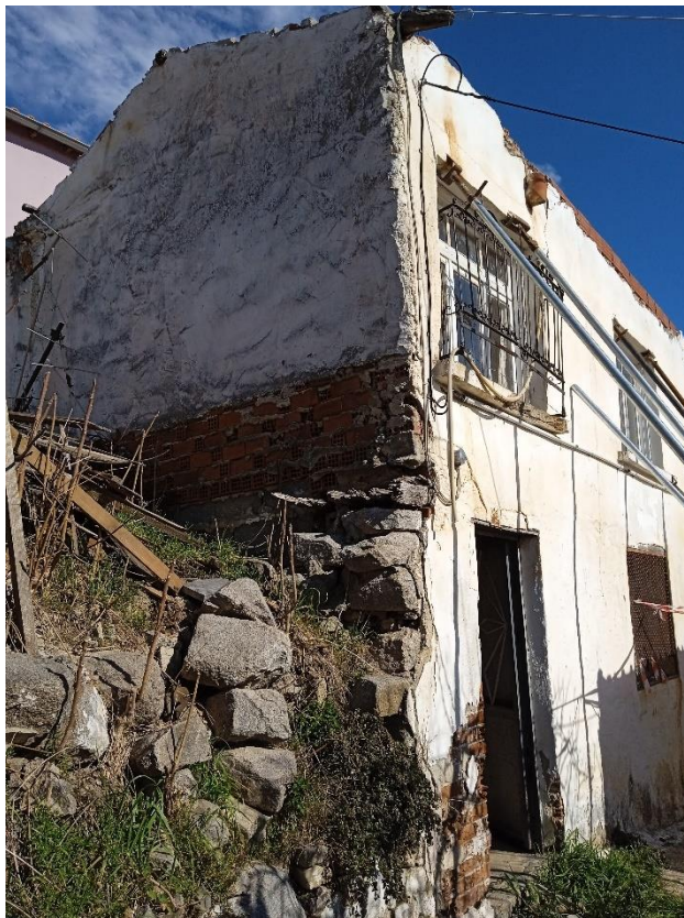
Φωτ. 2 Δυτική όψη του κτίσματος
