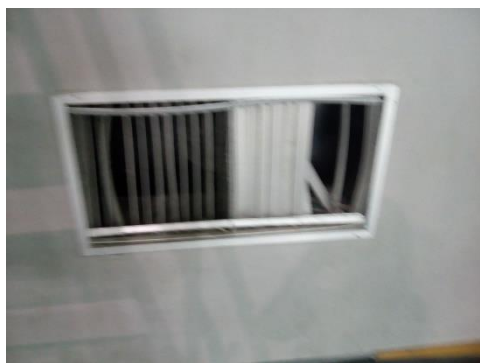
Εικόνα 1.7: Κατεστραμμένο στόμιο προσαγωγής – απαγωγής αέρα
