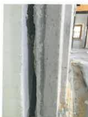
Εικόνες 119-124. Παραπάνω διακρίνονται οι θραύσεις, επικαθίσεις χρωμάτων και κονιαμάτων, η αποκόλληση και η προγενέστερη επέμβαση.
