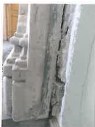
Εικόνες 119-124. Παραπάνω διακρίνονται οι θραύσεις, επικαθίσεις χρωμάτων και κονιαμάτων, η αποκόλληση και η προγενέστερη επέμβαση.
