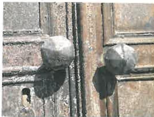
Εικόνες 67, 68. Κρακελάρισμα και απώλεια των χρώματος.
