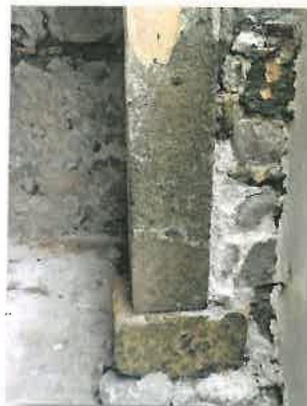
Εικόνα 106. βιολογικές επικαθίσεις
