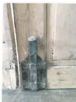
Εικόνες 58, 59. Μεντεσές και σύρτης συγκράτησης θυρών.
