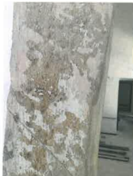
Εικόνα 110. Απώλειες χρωμάτων
