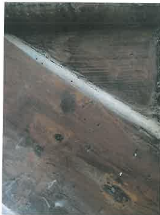
Εικόνα 20. Οπές από εντομοφάγα.
