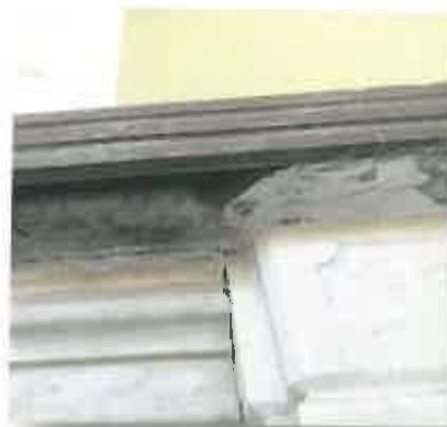
Εικόνες 125, 126. Θραύσεις στο μαρμάρινο οριζόντιο τμήμα
