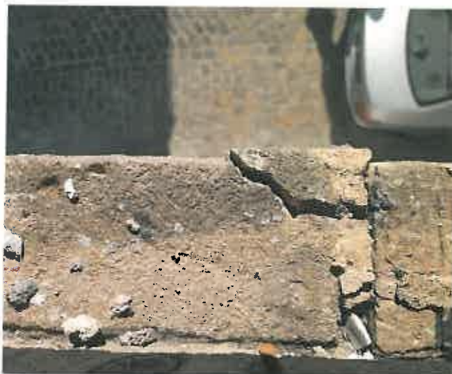
Εικόνα 108. Ετοιμορροπία τμημάτων στο γείσο της όψης
