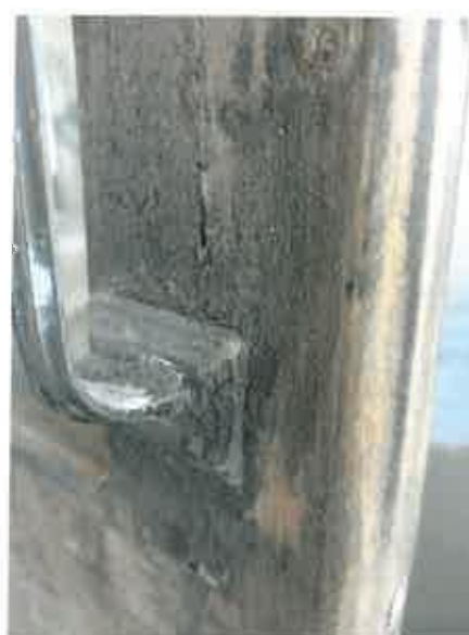
Εικόνες 25, 26. Επικαθίσεις χρωμάτων και αιωρούμενων σωματιδίων
