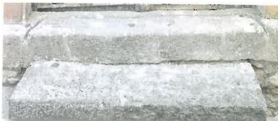
Εικόνα 100. Βαθμίδα από γρανιτικό πέτρωμα
