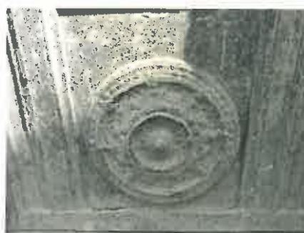
Εικόνες 61, 62. Επικαθίσεις χρώματος και κονιαμάτων
