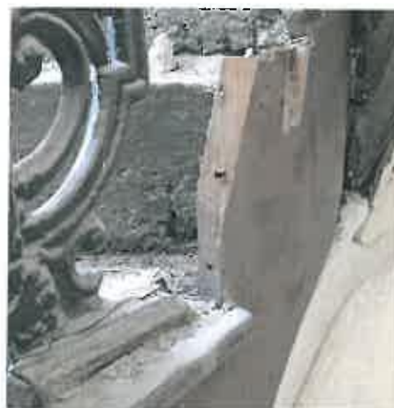
Εικόνες 17-18. Θραύση στο ρίχτι.
