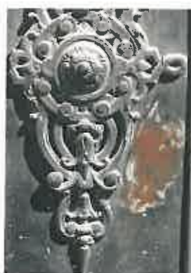
Εικόνες 61, 62. Επικαθίσεις χρώματος και κονιαμάτων
