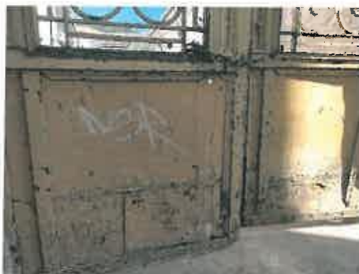
Εικόνες παράπλευρης εισόδου, απώλεια και οξειδώσεις.
