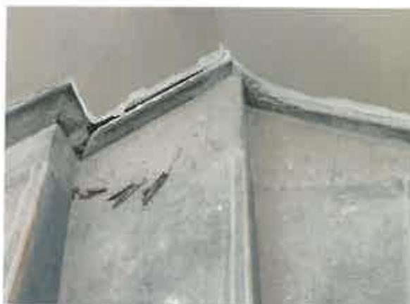
Εικόνα 16. Απώλεια στο σοβατεπί.
