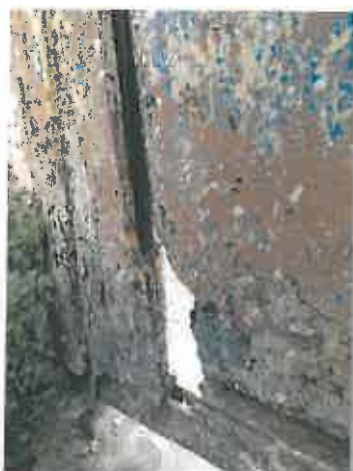
Εικόνες παράπλευρης εισόδου, απώλεια και οξειδώσεις.
